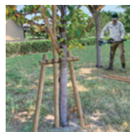
樹木の支柱設置に
