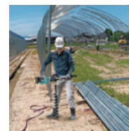
ビニールハウスの施工に その他現場作業に
