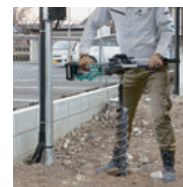
仮設電柱ポールの設置
